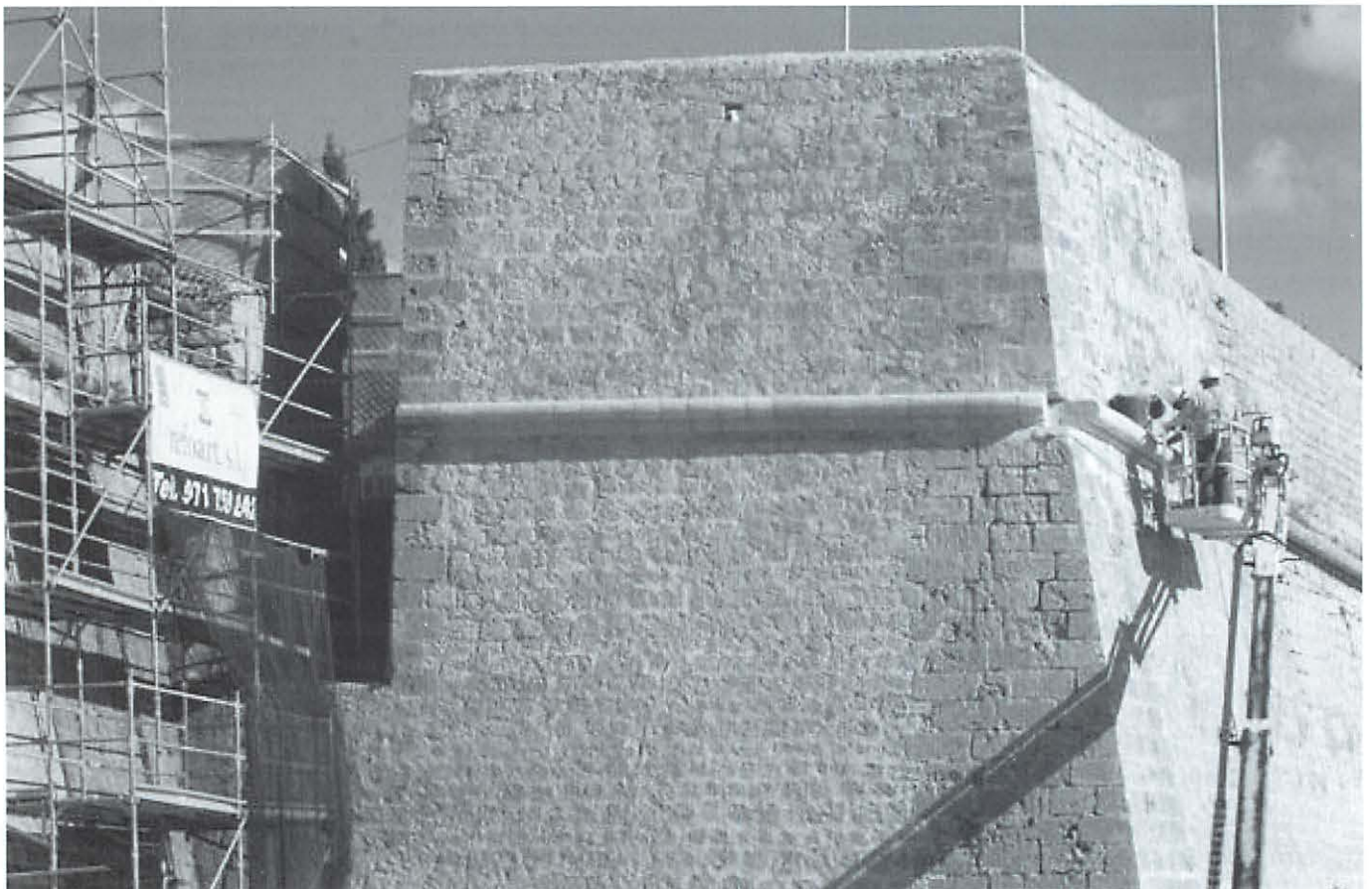
Restauració del Baluard de Santa Tecla. (Foto Moises Copa. Diario de Ibiza )
