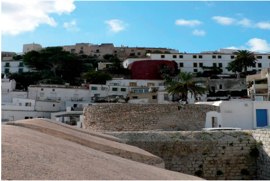
III. "Torre" del Seminari (núm. XVIII del plànol d'A Costa), des d'on baixava un tram de la murada del Raval fins a la torre núm. XXVIII. En aquest llenç s'obria la Porta Major del recinte
