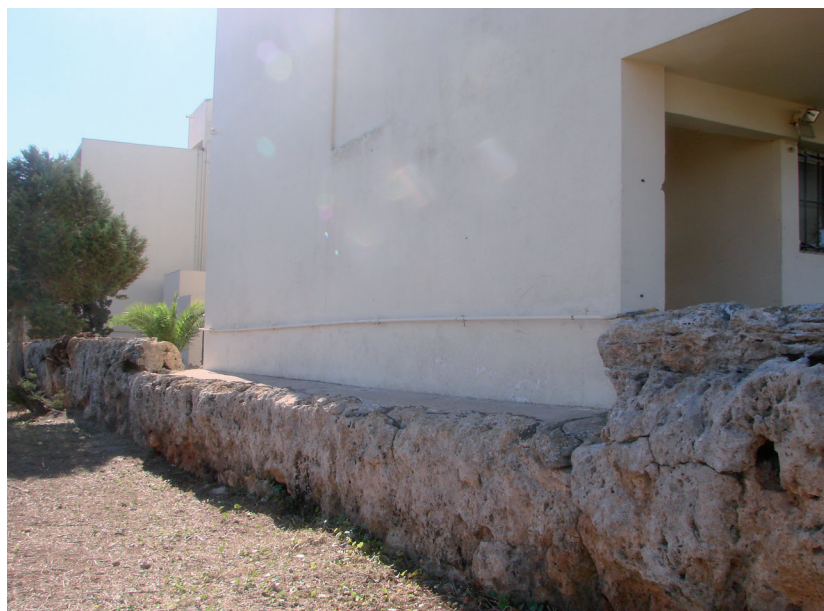
Vista de l'aqüeducte amb l'annex construït damunt d'ell
