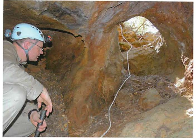
Fig. 7: Aspecto de la cámara de explotación a la que conduce G15 (estado antes de la limpieza, estado agosto 2013)
