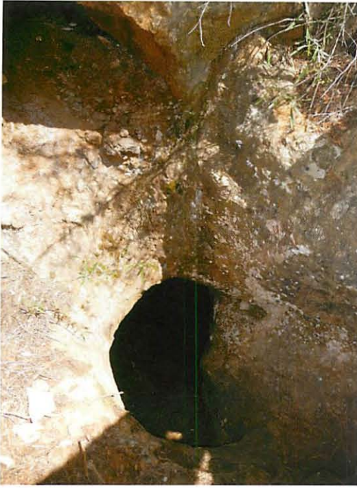
Fig. 6: Aspecto externo de la bocamina denominada G15. Véase el arranque de una galería en la parte superior de la fotografía, partida por el talúd posterior (estado abril 2014)
