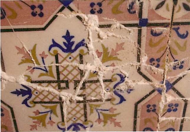
Fig. 5: Cristallitzacions salines entre les esquerdes del vidriat
