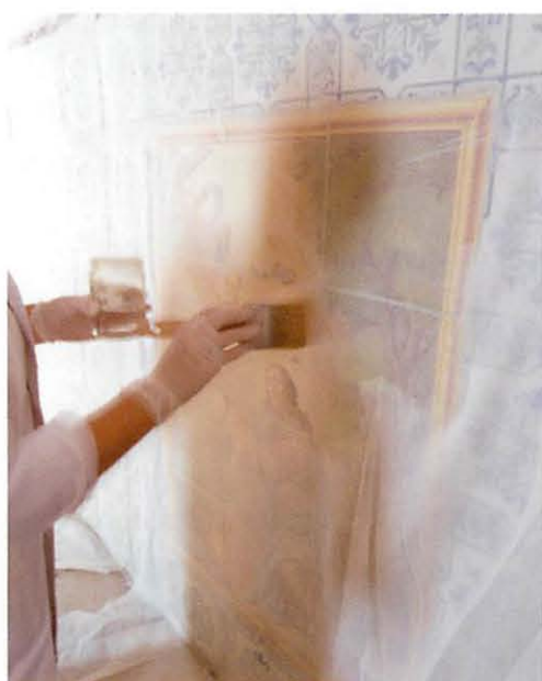
Fig. 11: Procés d'engassat
