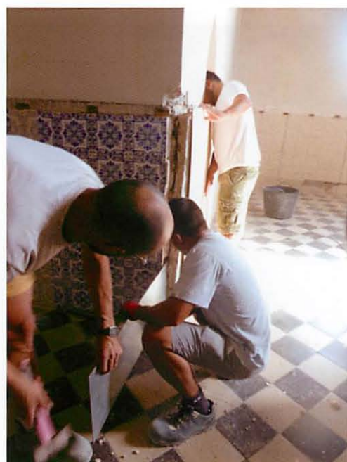
Fig. 12: Arrencament dels plafons ceràmics
