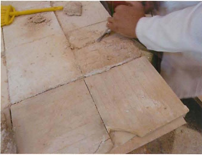
Fig. 14: Eliminació dels morters del revers
