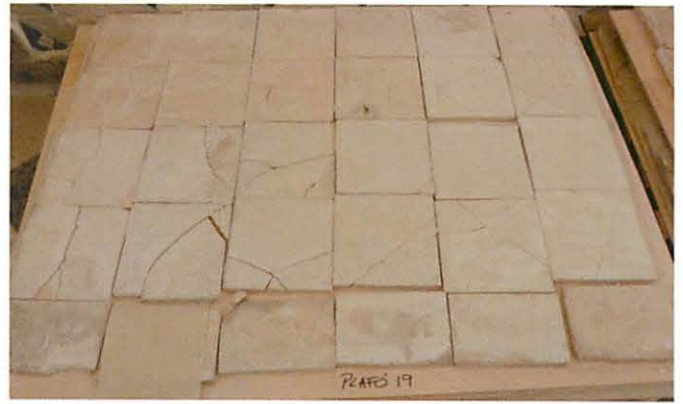
Fig. 13: Arrencament dels plafons ceràmics
