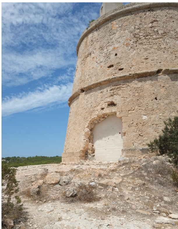
Figura 10. Torre des Pi des Català sobre los restos de un muro antiguo
