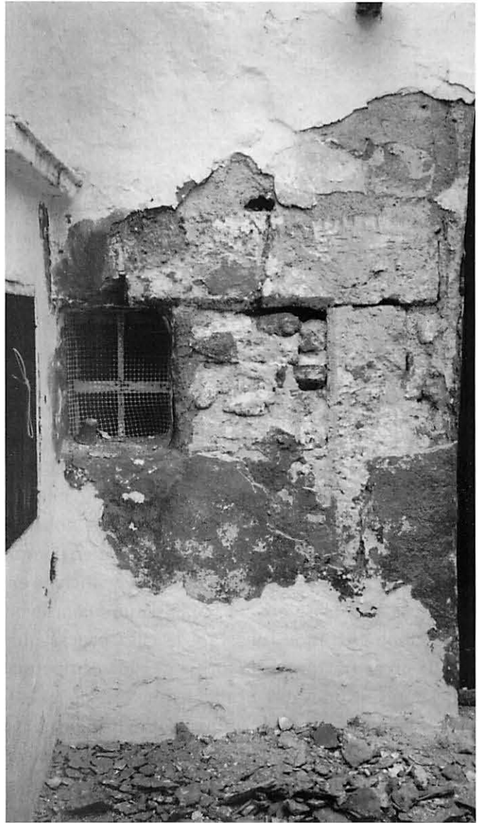
Detall de la façana sud, corresponent al cos primitiu de l'habitatge. S'hi aprecia l'antiga porta d'accés construïda en carreuat de marès, amb llinda conformada amb arc pla de tres dovelles, paredada en fer-se la que es veu a la dreta de la imatge. Observeu la reduïda alçada a què se troba la llinda, deguda al progressiu creixement de la cota del paviment al llarg de la història de l'edifici. (vegeu la secció transversal de la fig. 12.)
