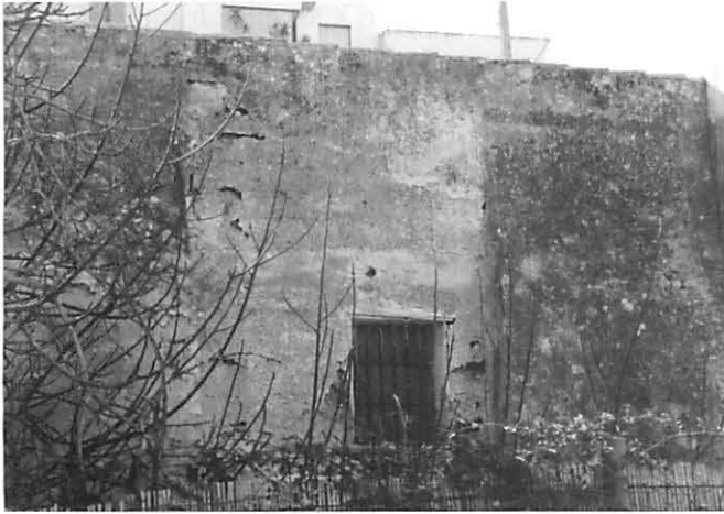
Detall de la façana posterior. Entre els dos grans contraforts de reforç s'aprecia l'antic mur de tàpia, amb les juntes de les tapieres i la crosta de calç amb restes d'un referit posterior.
