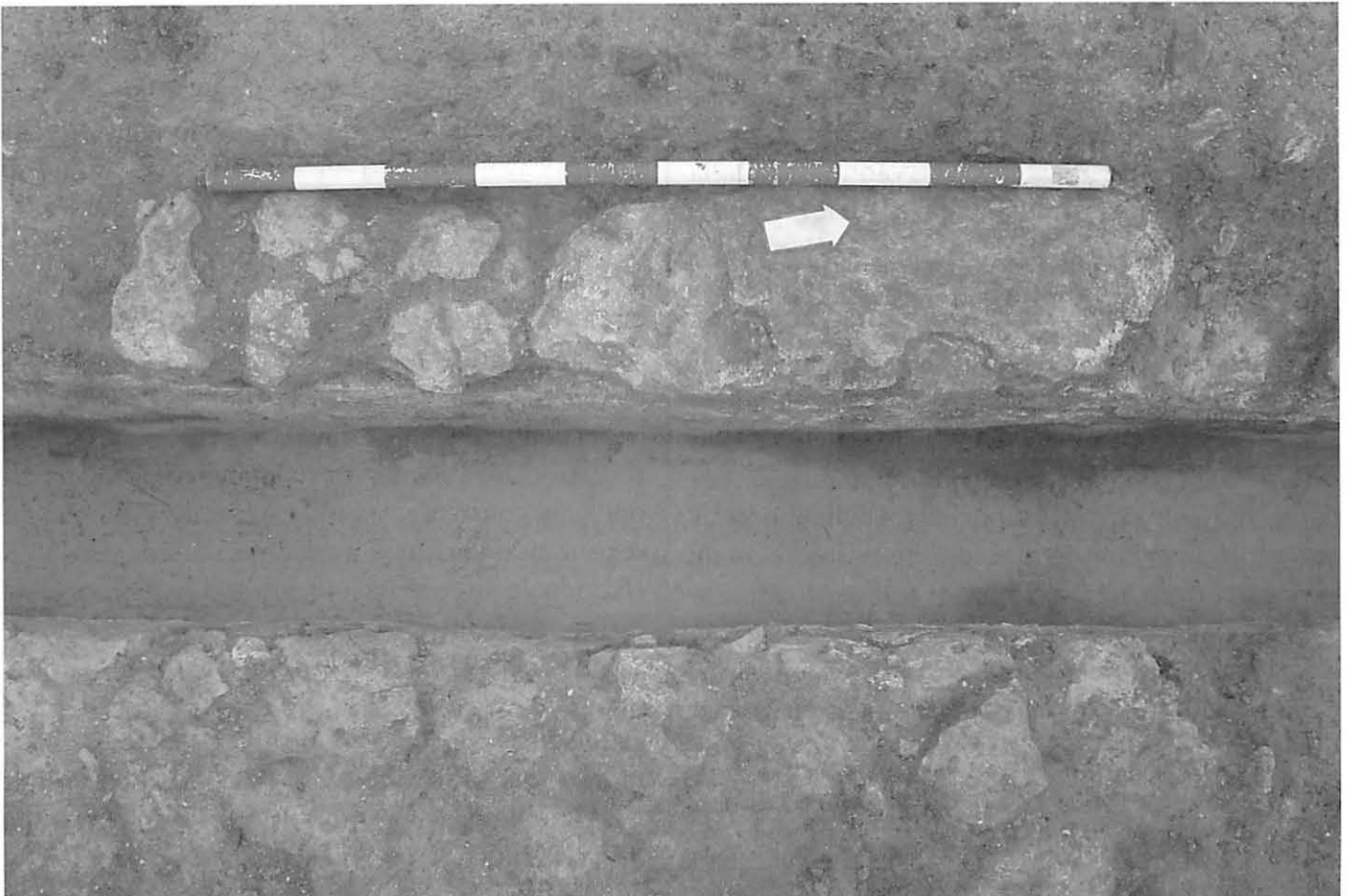
Foto 6. Detalle del specus del acueducto.
